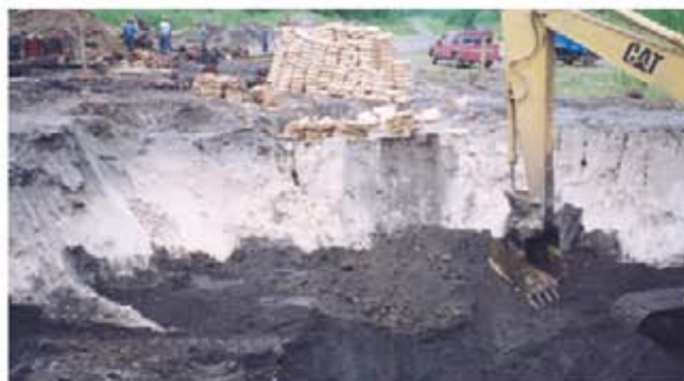
Texpet implementó un proceso remediación en ocho etapas.
