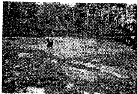
3) S.A. 53, Piscina 1: Trabajos de Remediación — Remoción de agua y petróleo durante lavado de suelos, 1996.
